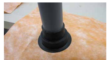
Manschette mit Gummimuffe zur Durchführung von DN 50-DN70 Abflussrohren (System Dallmer).
